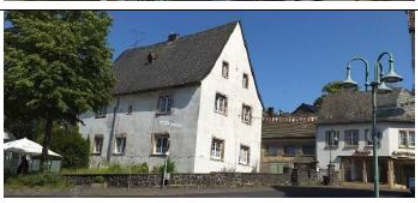
Burgfriedstraße 1 Putzbau, 16. Jh., Eingang barock überformt
