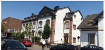
Leopoldstraße 29 Verwaltungsgebäude; barockisierender Mansarddachbau, Anfang 20. Jh.
