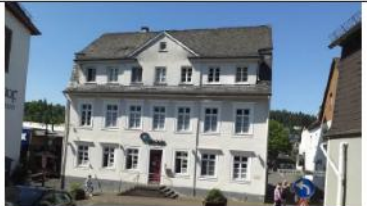
Burgfriedstraße 25 ehem. Bürgermeisterei, siebenachsiger klassizistischer Mansarddachbau, 2. Hälfte 19. Jh.
