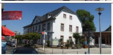
Leopoldstraße 9 ehem. Landratsamt, siebenachsiger klassizistischer Krüppelwalmdachbau, 1830/31 (heute Museum)
