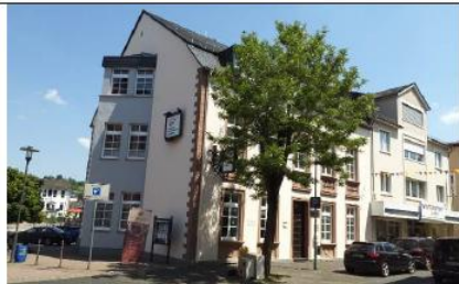
Wirichstraße 16 ehem. Amtsgericht, traufständiger Putzbau, 1860
